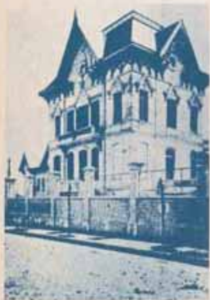
Casa de Aislamiento, 1899.
