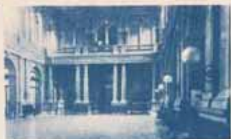
Interior de la Bolsa de Valores. Arqs. Shunt y Schroeder, 1862.
