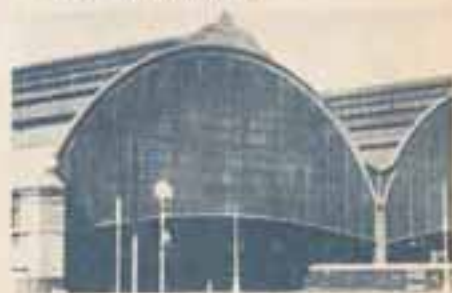
Andenes de la Estación Retiro. Arq. Lauriston Conder, 1905.
