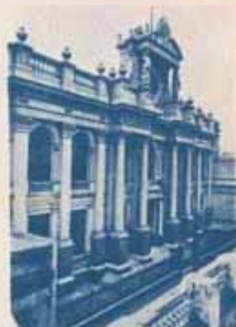
Banco Hipotecario. Arquitecto Buschiato, 1880.
