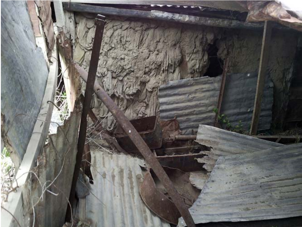
Sistema de muro interno con bolsas mojadas en barro.
