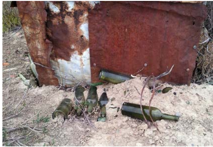
Letrina posterior: véase el borde del pozo hecho con botellas de vidrio que ahora asoman por la erosión, para la rapiña de los visitantes.
