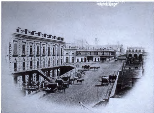
Fig. 11.5 The Annex of the Customs: note Taylor's use of the unevenness of the land for entering the different floors of the building (Archivo General de la Nación)
