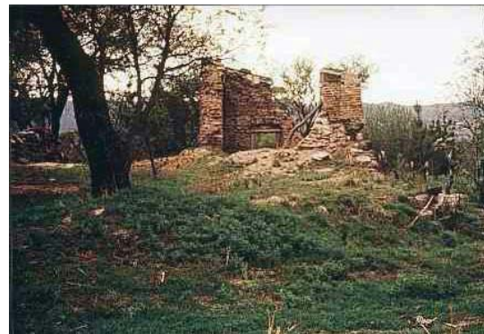
Figura 3: Uno de los edificios en 1962 con derrumbe reciente del muro posterior
