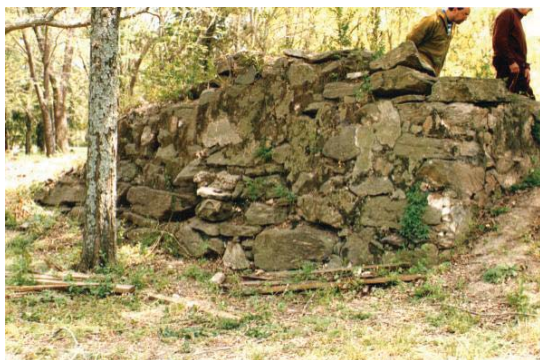
Figura 7: Restos de los muros de piedra de la iglesia (2003)
