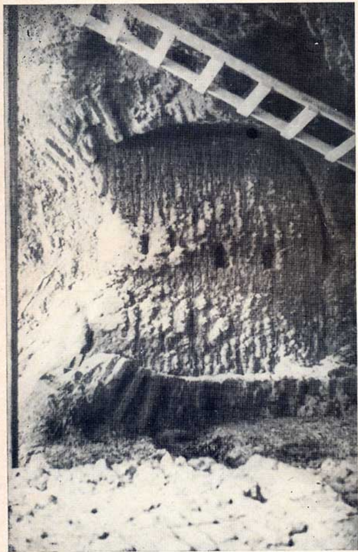
El espesor de la mampostería y tipo de construcción puede apreciarse en esta foto obtenida en el subsuelo de la calle Moreno al 400.
