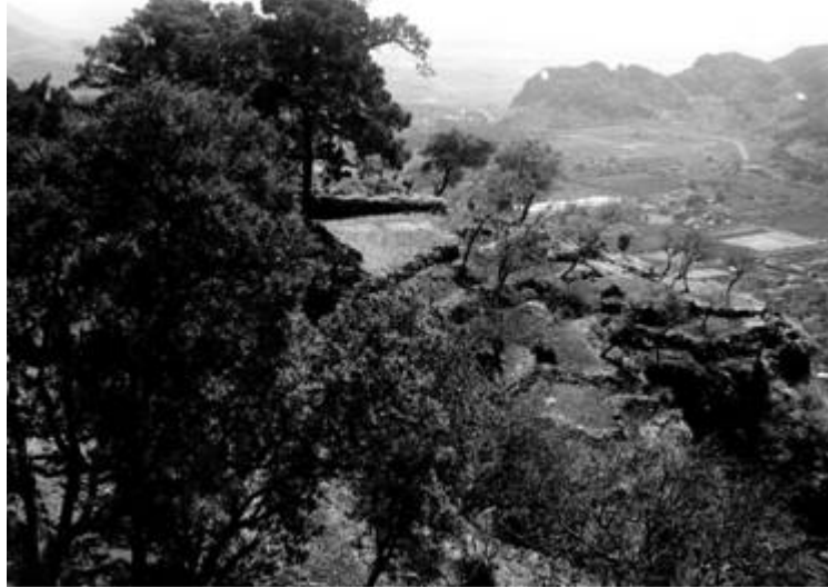
Vista del conjunto de plataformas y restos de las construcciones anexas (1980).
