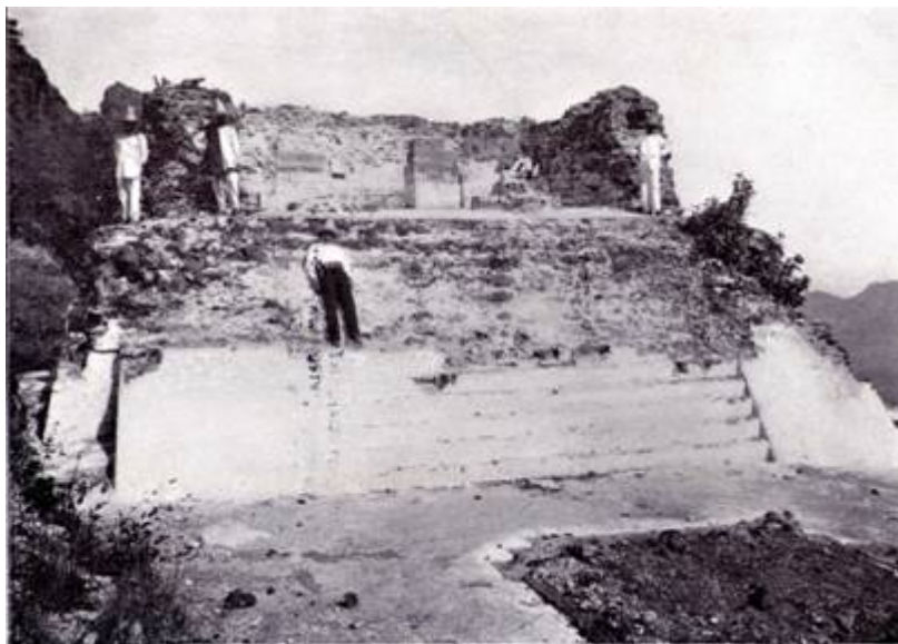
Foto al finalizar la excavación de la construcción.
