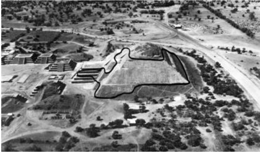
Grandes obras de restauración en la pirámide de la Luna en Teotihuacán hechas por Rodríguez en sus dos intervenciones.
