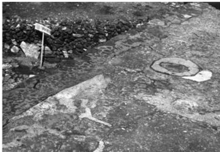
Restauración moderna que incluye la firma del responsable, en el cemento del piso.
