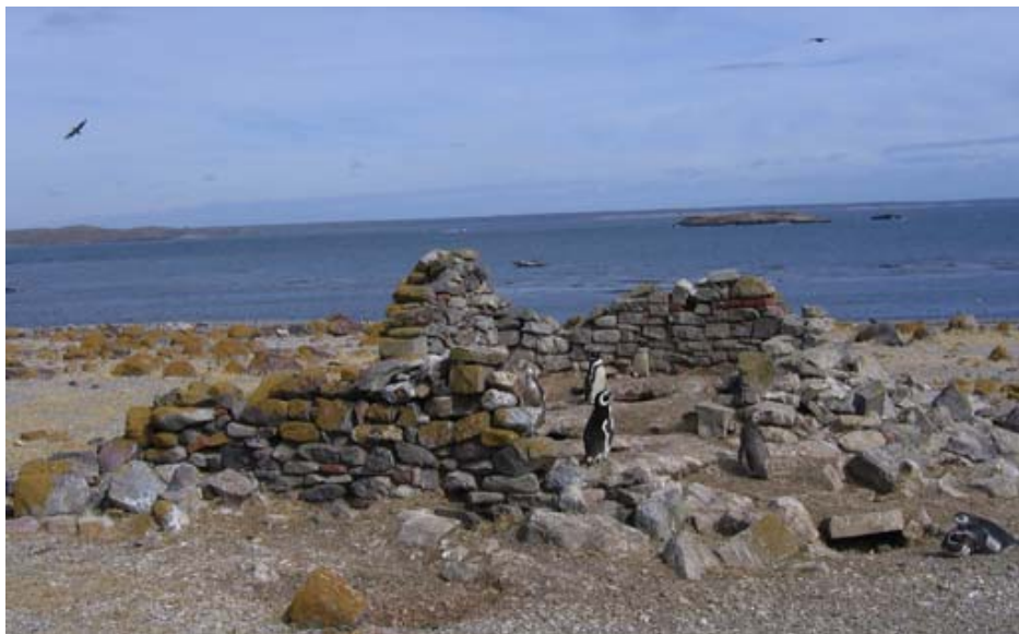
Restos de edificación de la Real Compañía en la Isla Pingüino en la actualidad. El sistema constructivo es igual al del Fuerte.
